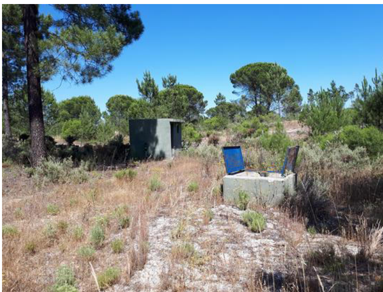
Fotografia 4.2 – Furo de pesquisa de captação executado em 2008
